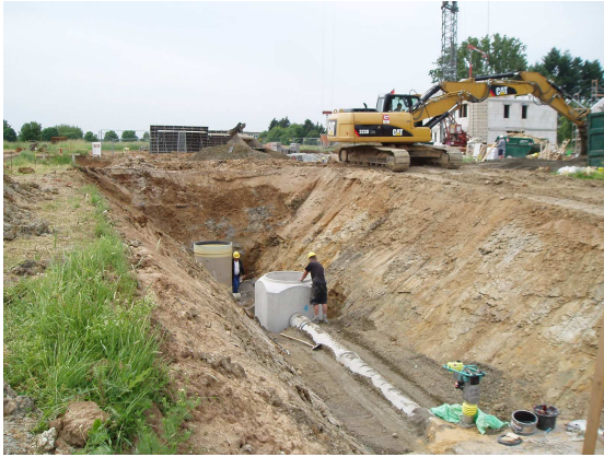
abgeböschter Kanalgraben
