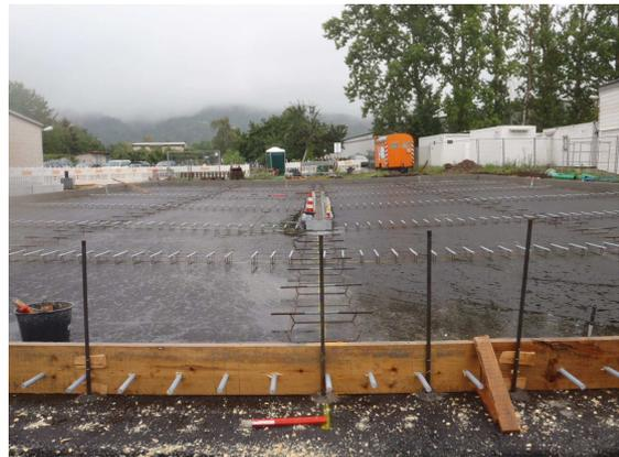
Vorbereitung Dübel & Ankerlagen vor der Betonage BA3
