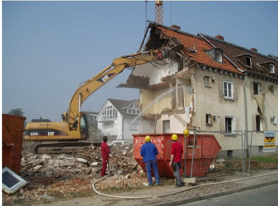
maschineller Rückbau mittels Separiergreifer
