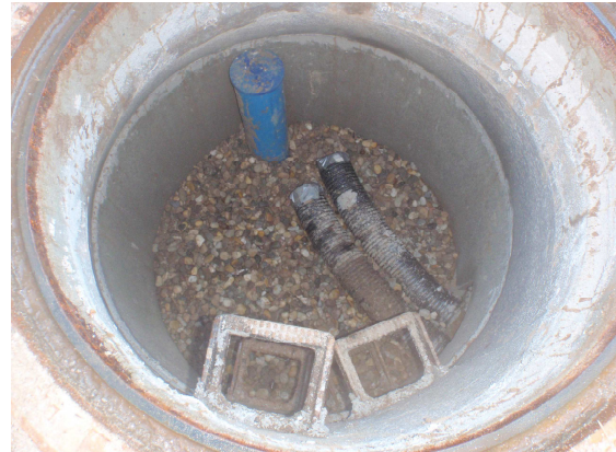
neuer Sanierungsbrunnen mit Leerrohren zur Pumpenmontage
