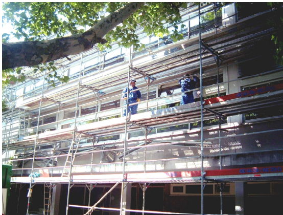
Eingerüstete Ostfassade vor der Sanierung der PCB-haltigen Fugendichtmassen
