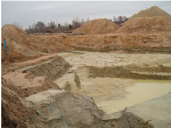
Baugrube ehem. Gasanstalt
