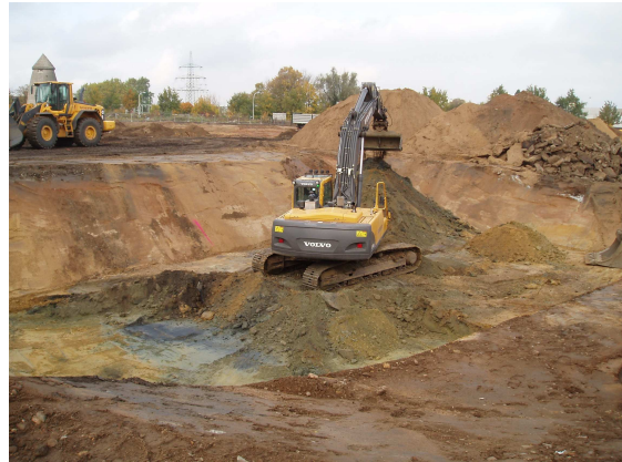
Baugrube ehem. Ölkeller
