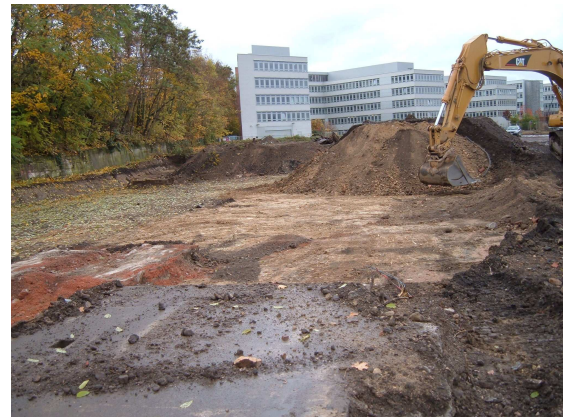
Aushub und Separation Boden und belastete Auffüllung
