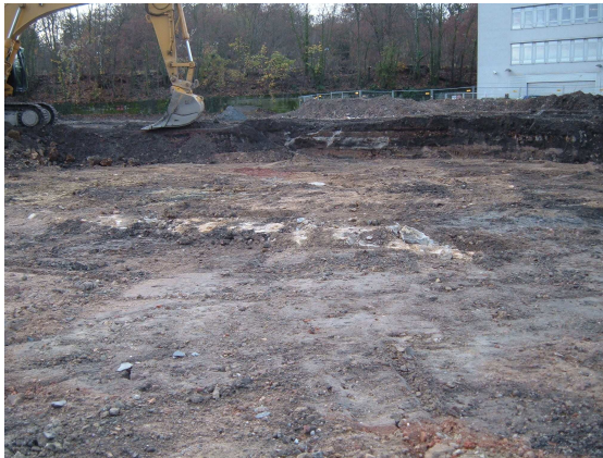
Aushub der kontaminierten Deckschichten
