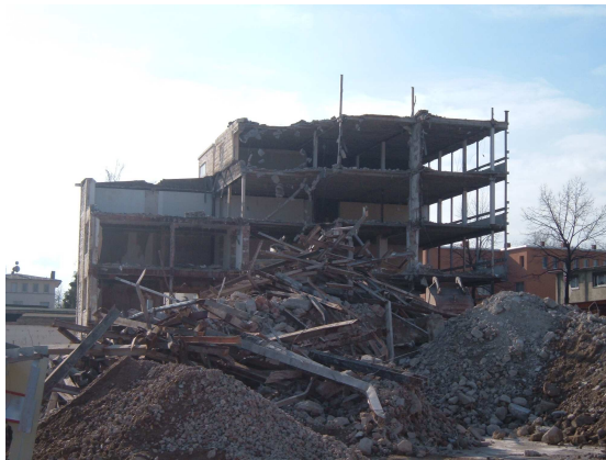
Rückbau und Separation der Bausubstanz
