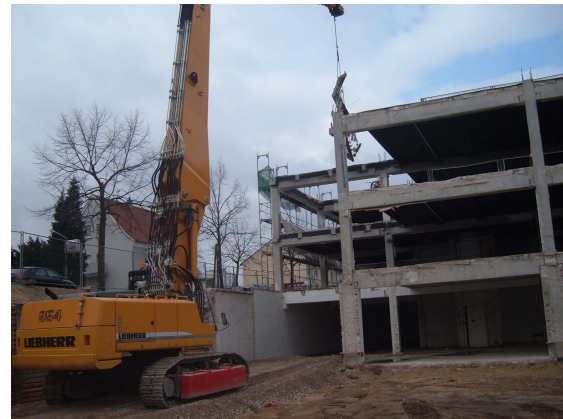
Rückbau unter Beachtung der Baustatik
