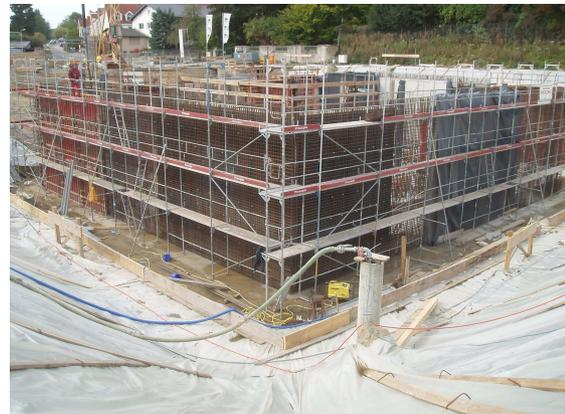
Herstellung der Wände des Regenrückhaltebeckens, im Vordergrund Brunnen zur Grundwasserhaltung
