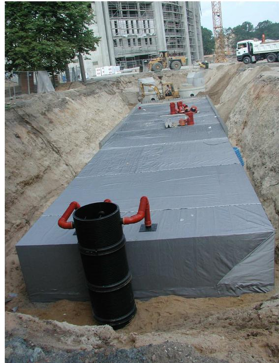
Versickerungsrigole mit Geotextil ummantelt
