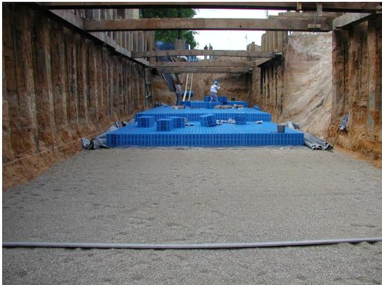
Einbau der Kunststoffkörper in großer Tiefenlage
