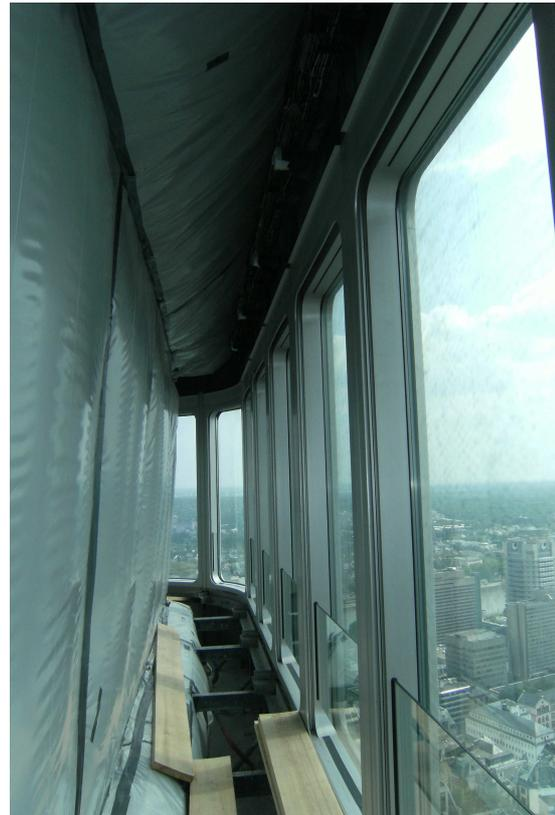
Schwarzbereich zur Sanierung der Fassadendichtung
