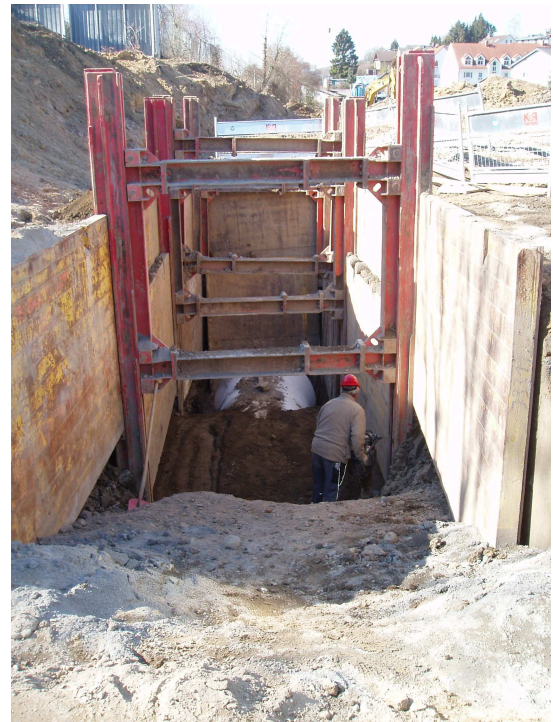
Linearer Gleitschienenverbau f. DN 1400 Stb
