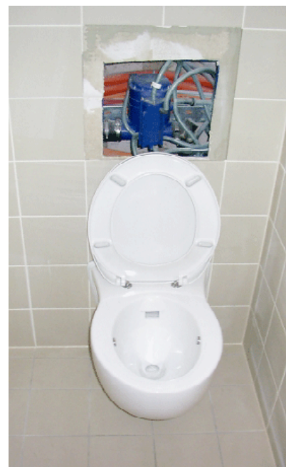
Abb.: 2.2-2: Vakuumtoilette
