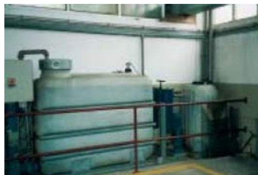
Abb. 2.2-6: Speicher Buswaschanlage
