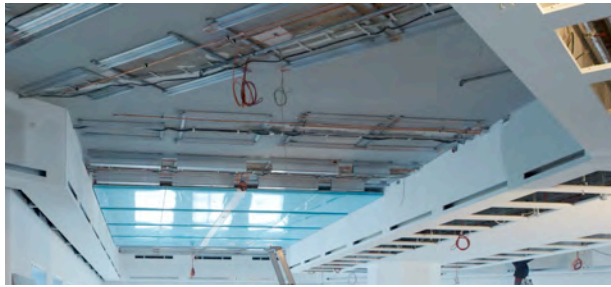
Unterkonstruktion der Heiz-/Kühldecken mit Aktivierungsprofilen
