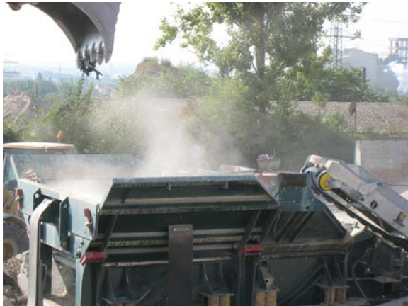
Bild 2 Staubentwicklung bei der Bauschutt aufbereitung
